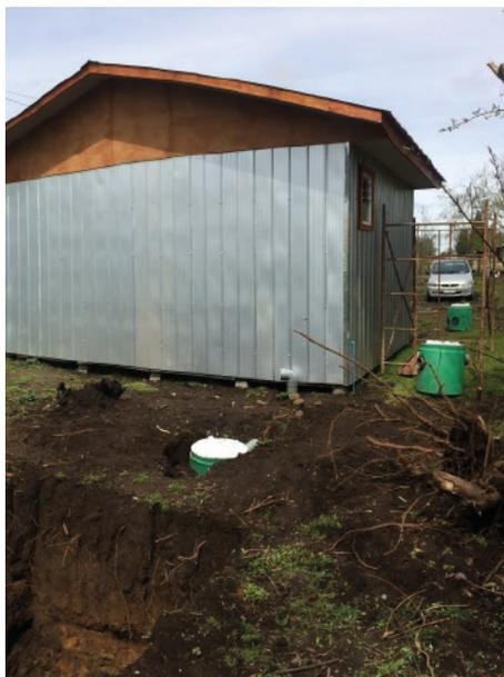
Instalación de sistema de fosa séptica, donde se aprecia la cámara desgrasadora instalada, la perforación de la fosa a la izquierda y la cámara repartidora de drenes que todavía no se instala.
