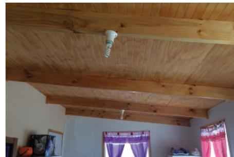
Revestimiento interior (cielo entablado madera).
