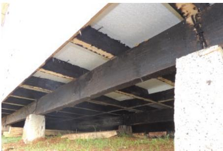
Aislación hídrica y térmica piso ventilado.
