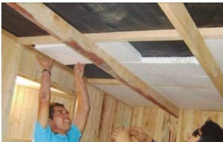
Instalación de aislación térmica (cielo).
