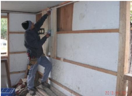
Instalación de aislación térmica (muro).
