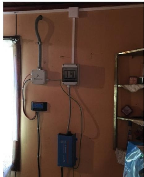
Sistema de conexión a panel fotovoltaico.
