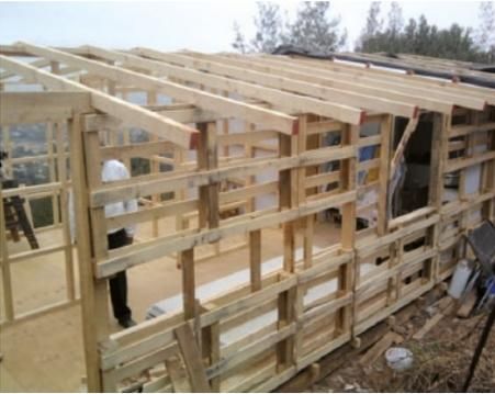
Estructura muro y techos de madera
